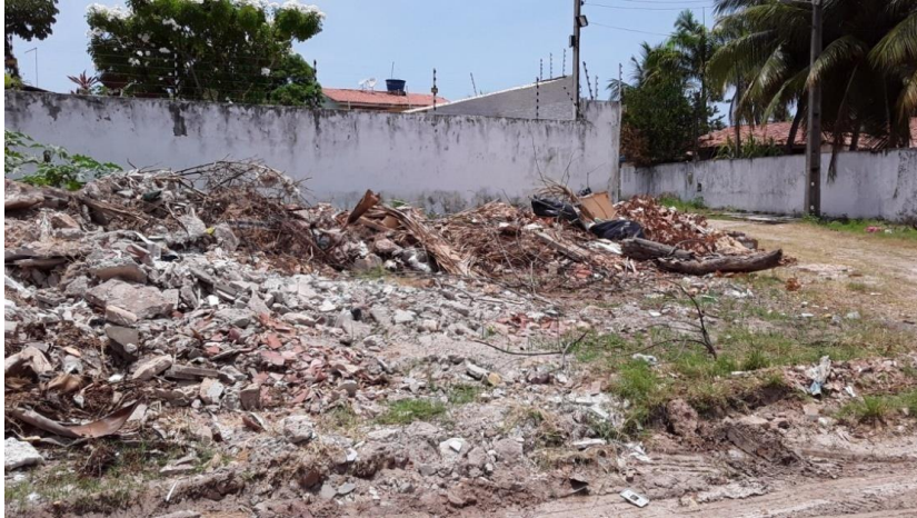
Figura 13 – Descarte irregular de resíduos de construção
