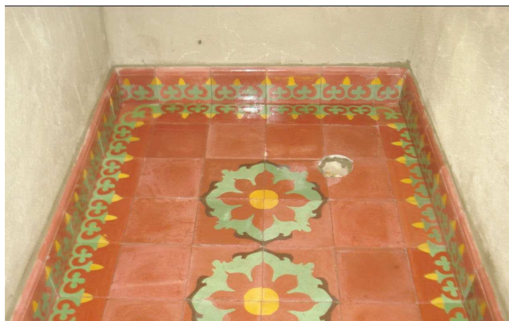
Figura 19: Rodapé de ladrilho hidráulico
