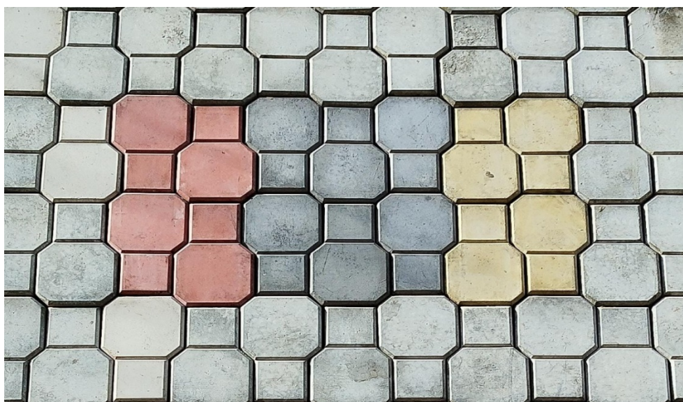
Figura 11 – Piso intertravado tipo IV, Raquete
