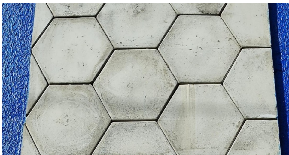
Figura 10 – Piso intertravado tipo III, sextavado
