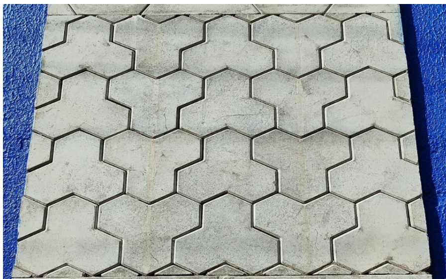
Figura 9 – Piso intertravado tipo II
