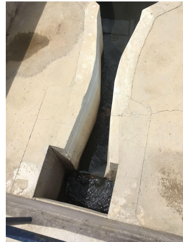
Figura 4: Calha Parshall
