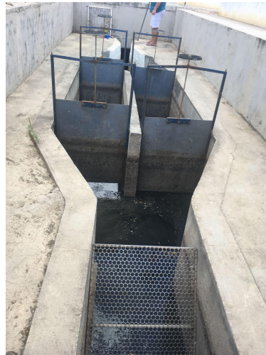
Figura 3: Desarenador
