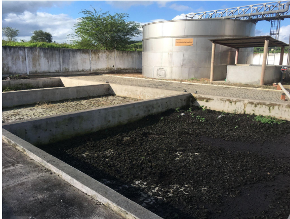
Figura 11: Leitões de Secagem
