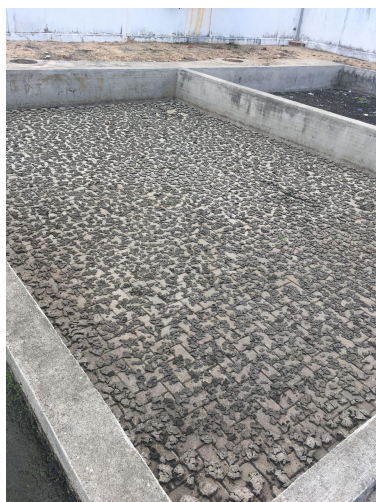
Figura 32: Leito de Secagem
