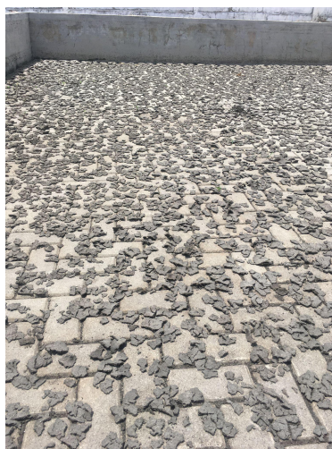
Figura 33: LE no Leito de Secagem
