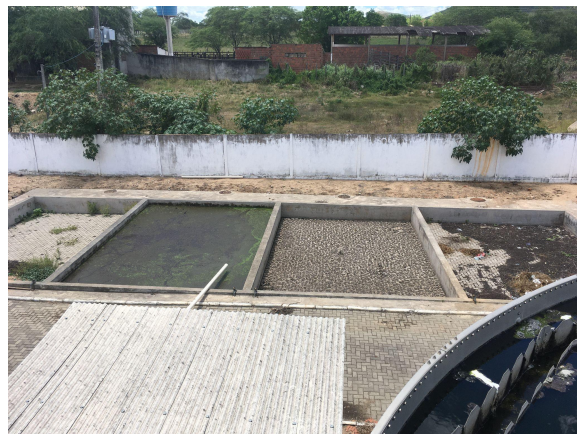
Figura 10: Leitos de Secagem
