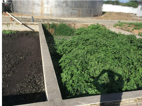
Figura 12: Leitões de Secagem
