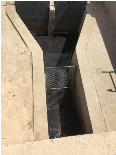
Figura 2: Gradeamento
