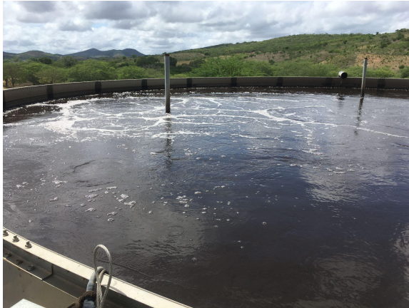
Figura 5: Tanque de Aeração
