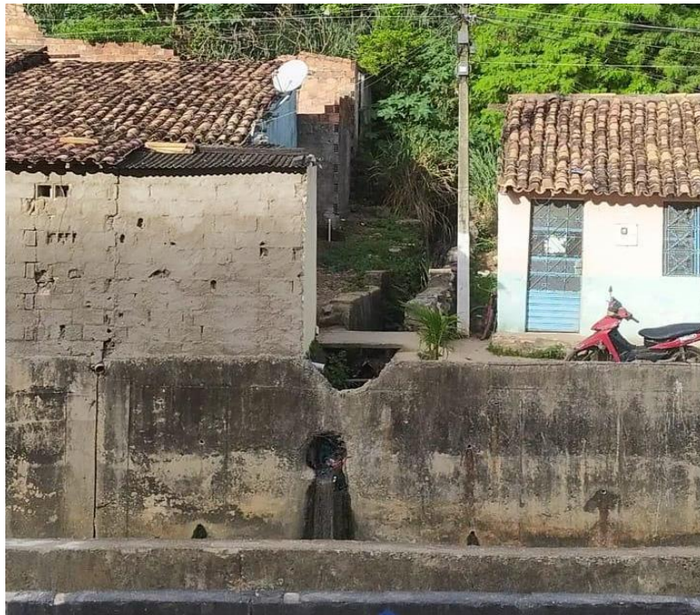
Figura 12: Ligação irregular de esgoto no Riacho Reginaldo
