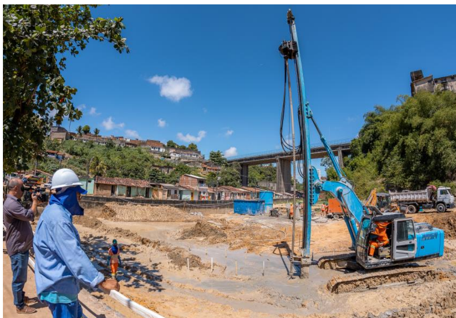
Figura 30: Obra da lagoa filtrante no Riacho Pau D'Arco
